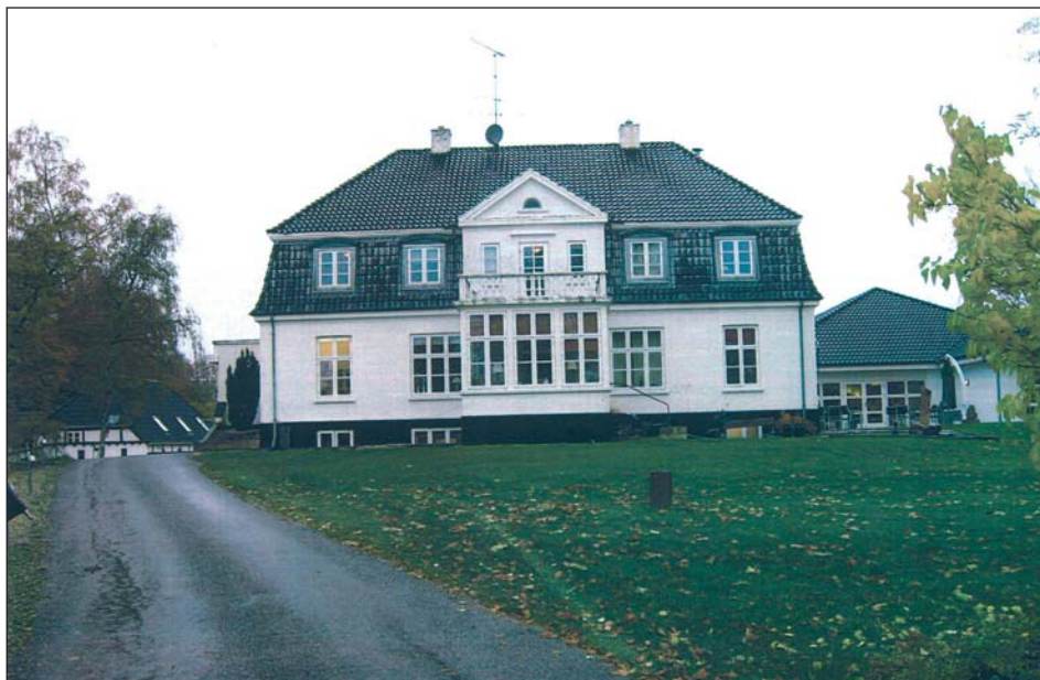
Lokalplanområdet med den eksisterende bebyggelse set fra syd med den bevaringsværdige bygning i forgrunden.
